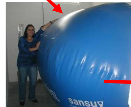
Gasômetro: armazenador de biogás
